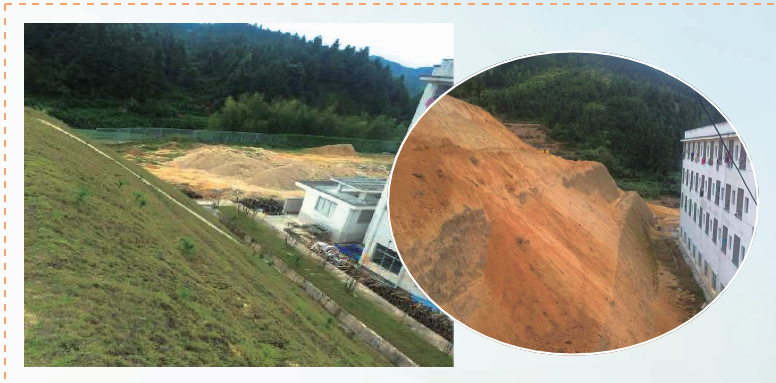
施工前后现场照片
