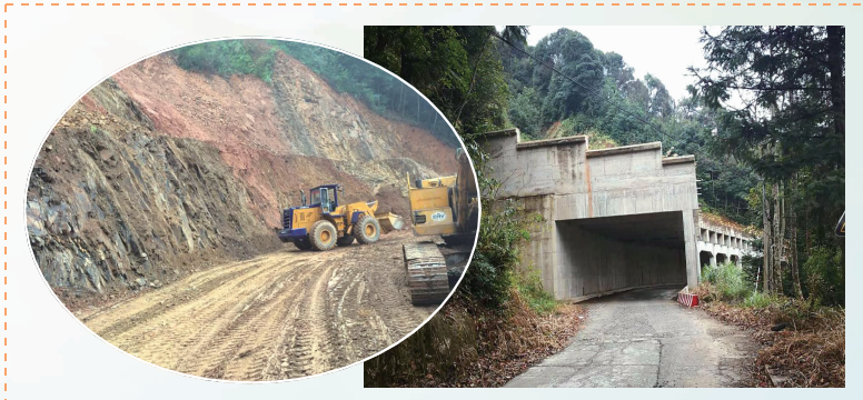
施工前后现场照片
