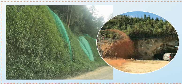
施工前后现场照片
