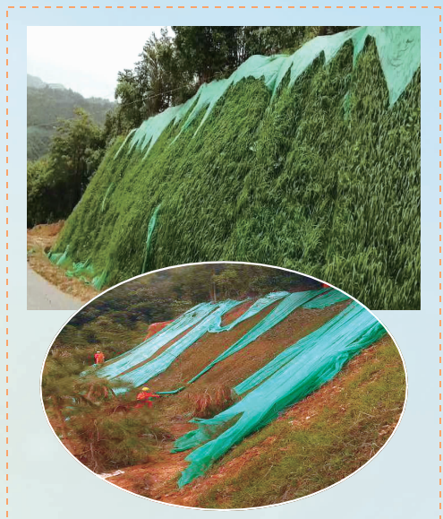
施工前后现场照片
