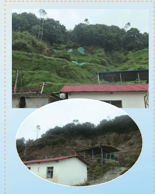
施工前后现场照片
